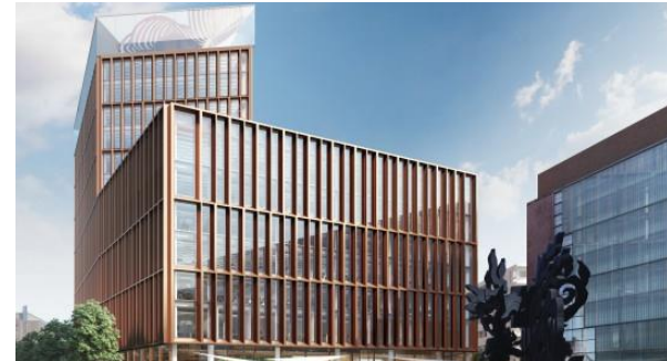
UUDISRAKENTAMINEN: We Land -toimistotalo, Helsinki
