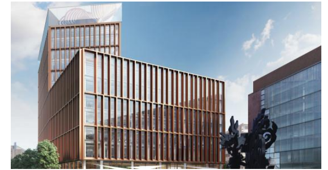
UUDISRAKENTAMINEN: We Land -toimistotalo, Helsinki
